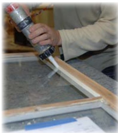
Energiglas monteras och kittas
