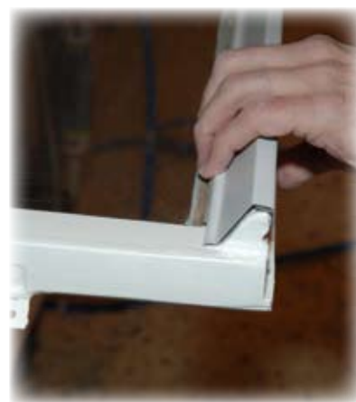
Droppnåsan skyddas med ventilerad plåt-skoning
